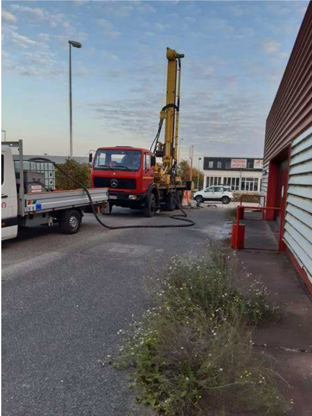
Foto 1: Operazioni di sondaggio S1
