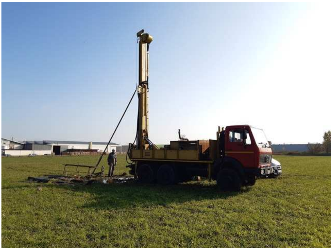
Foto 4: Operazioni di sondaggio S2
