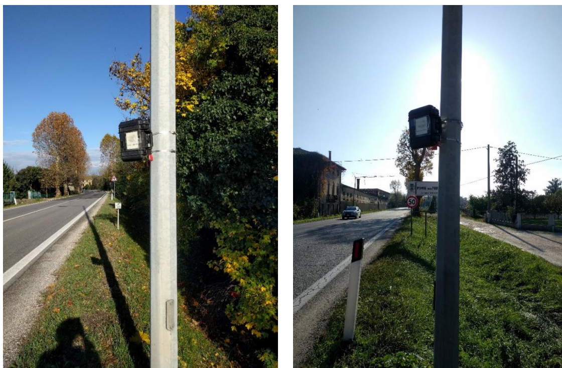
Figura 5: Posizionamento radar lungo la S.S. 13
