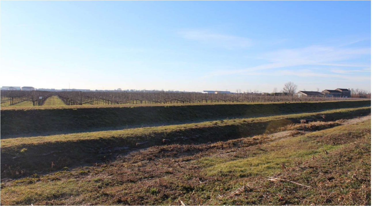
Argine Torrente Ruio, vista dell'area agricola
