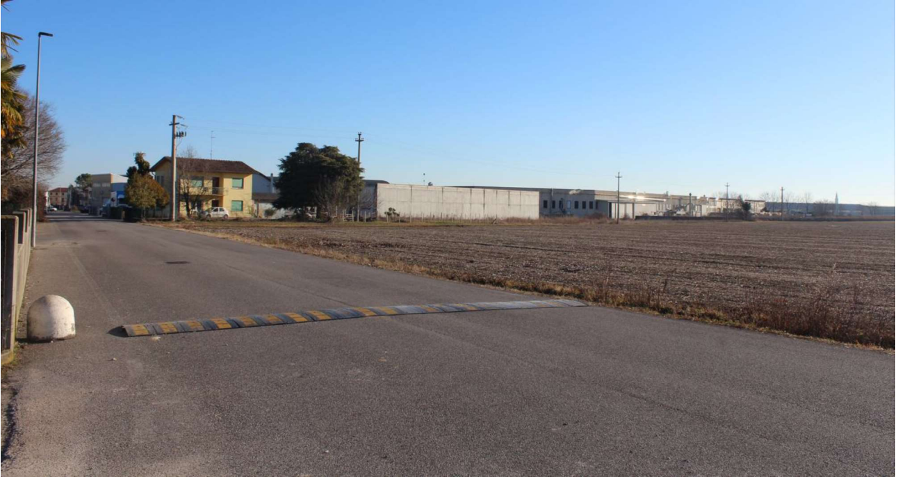
Via Foresto, vista dell'angolo Nord-Ovest del lotto del PdL
