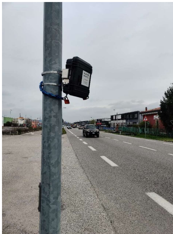
Figura 8: Dispositivo radar installato su SS 13 (via Conegliano)
