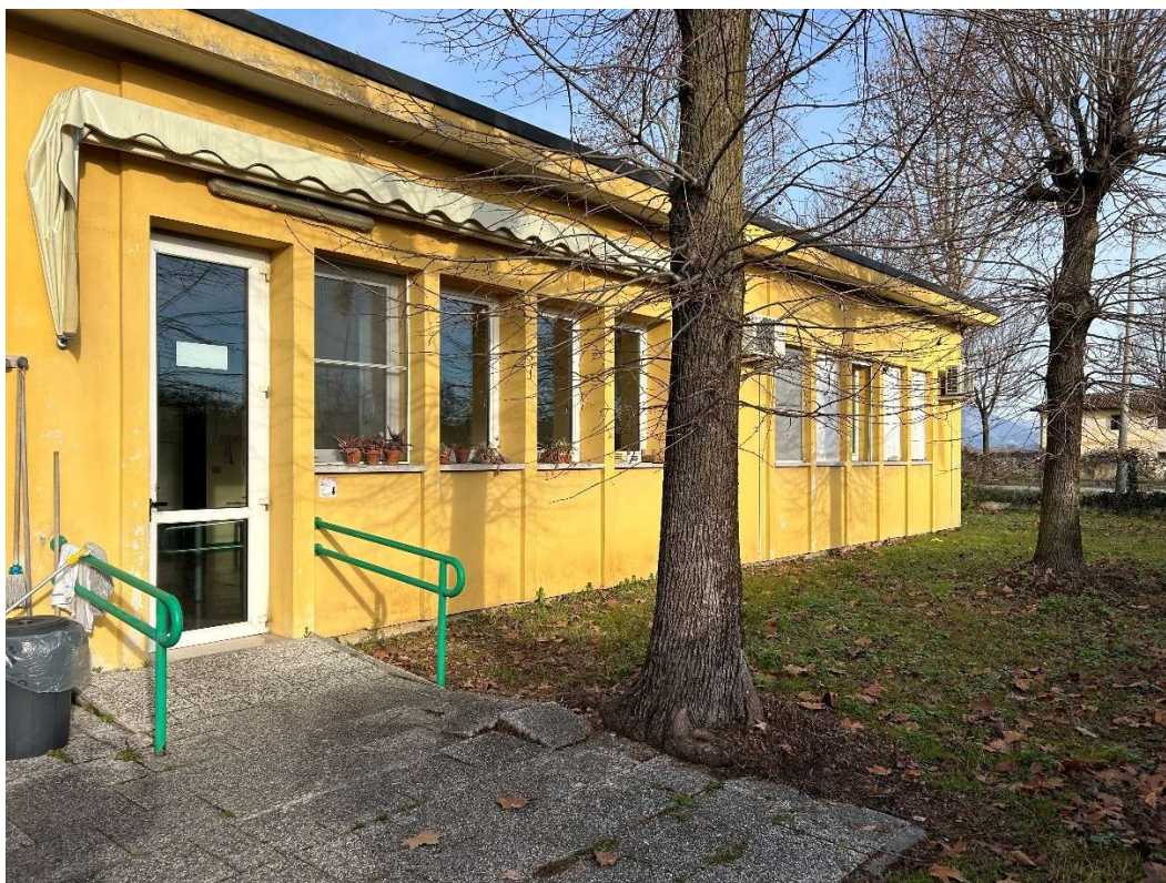
Figura 14. Vista esterna da sud-est
