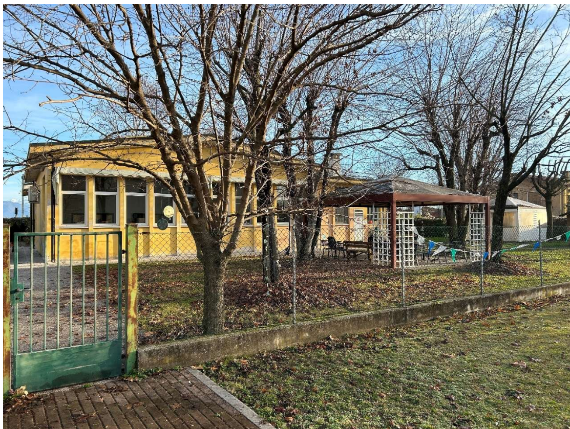
Figura 12. Vista esterna da sud-ovest
