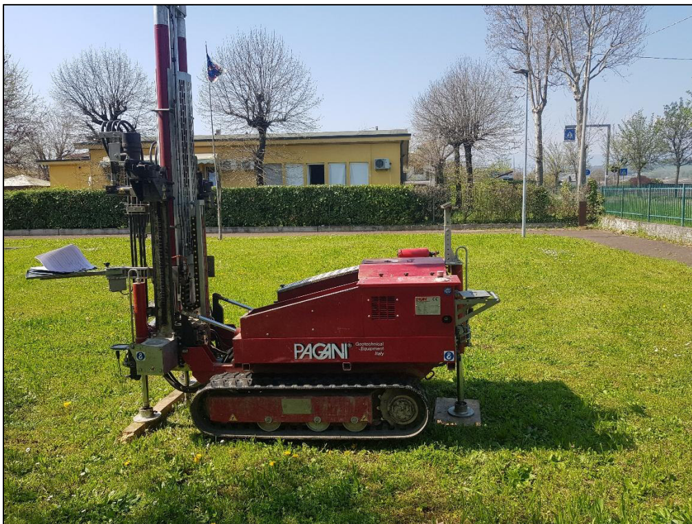
Foto n.3 – Esecuzione prova penetrometrica dinamica superpesante (DPSH3).
