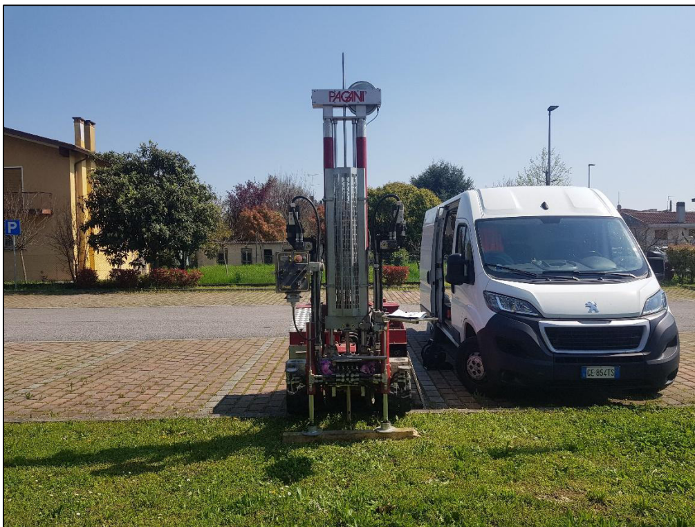
Foto n.1 – Esecuzione prova penetrometrica dinamica superpesante (DPSH1).
