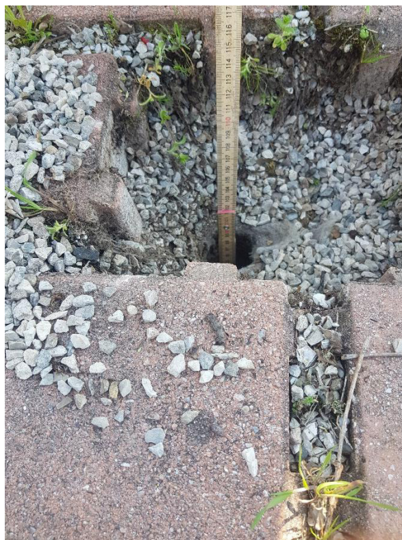
Foto n.9 – Esecuzione prova di permeabilità K2
