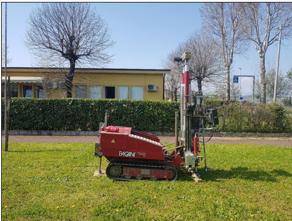
Foto n.2 – Esecuzione prova penetrometrica dinamica superpesante (DPSH2).
