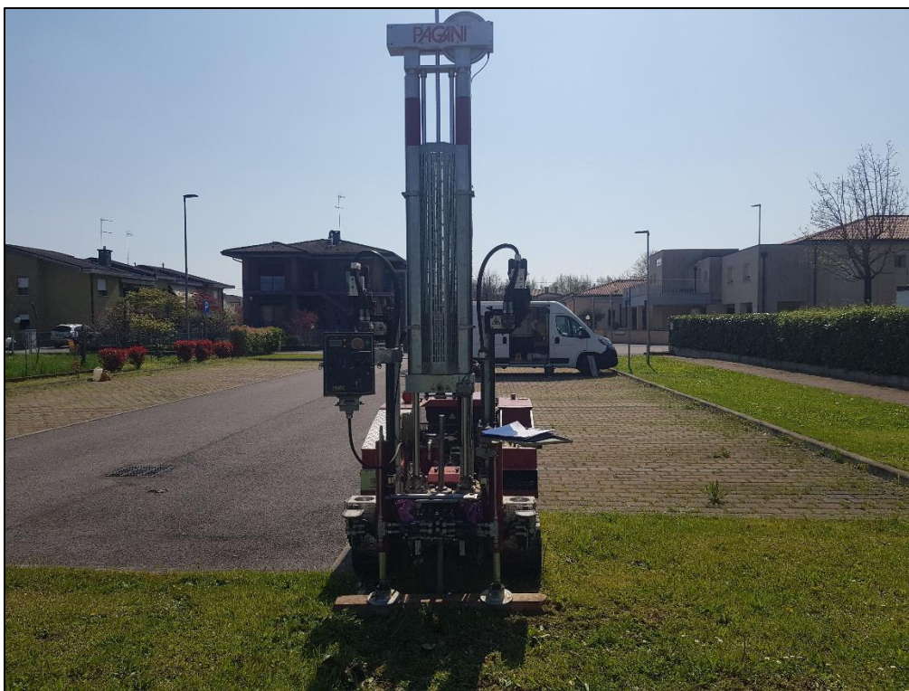
Foto n.4 – Esecuzione prova penetrometrica dinamica superpesante (DPSH4).
